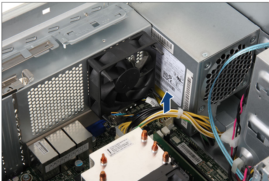
図 53: 背面ファンケーブルの取り外し
